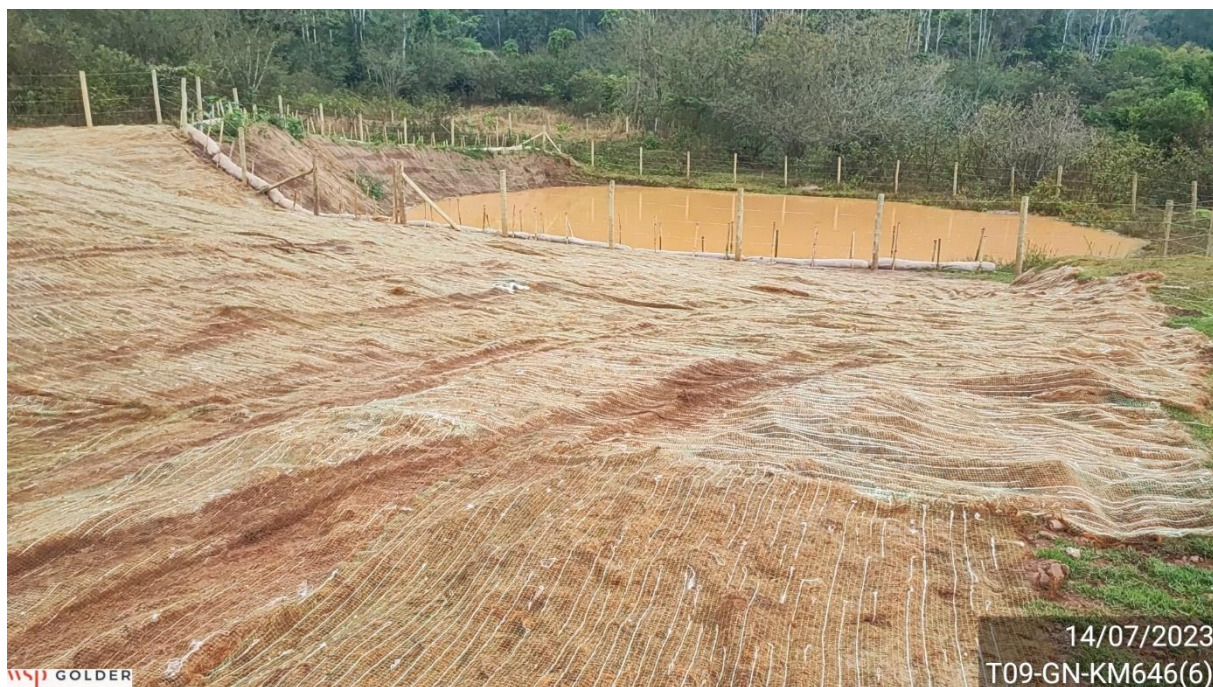
Figura 23 - Área de secagem da lagoa T09-GN-KM646 (6) finalizada
