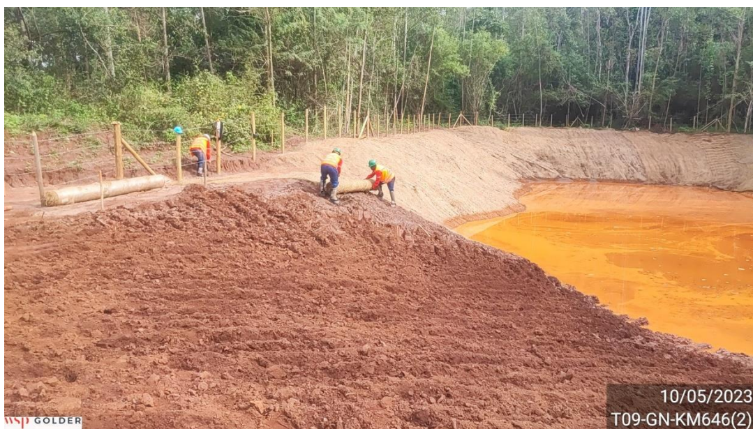
Figura 9 - Instalação de biomantas
