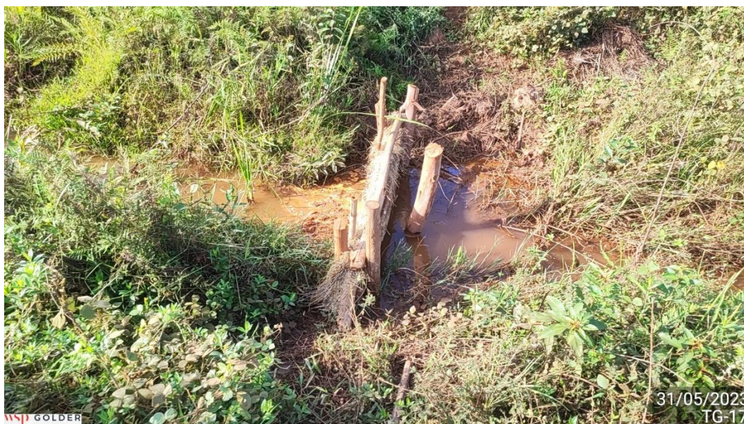
Figura 12 - Instalação de paliçadas nos tributários para retenção de sedimento
