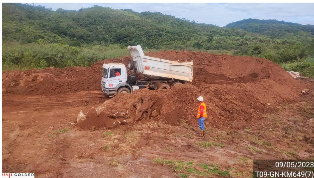
Figura 4 - Disposição do material escavado nas áreas de secagem
