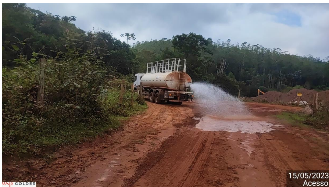
Figura 8 - Umectação das vias para minimizar a emissão de particulados
