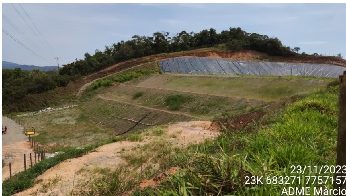
Figura 59 - ADME revegetada após a distribuição dos rejeitos, material argiloso e compactação.
