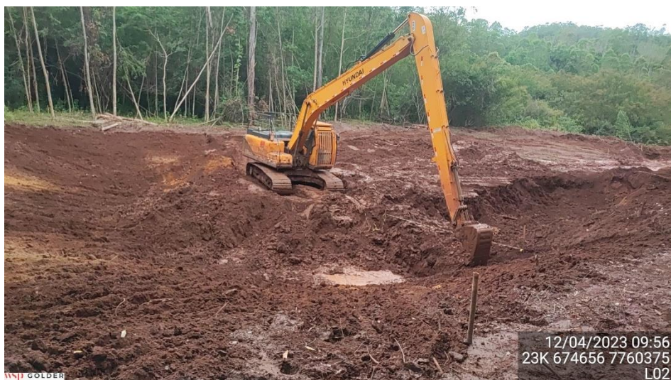
Figura 2 - Escavação do material no interior das lagoas
