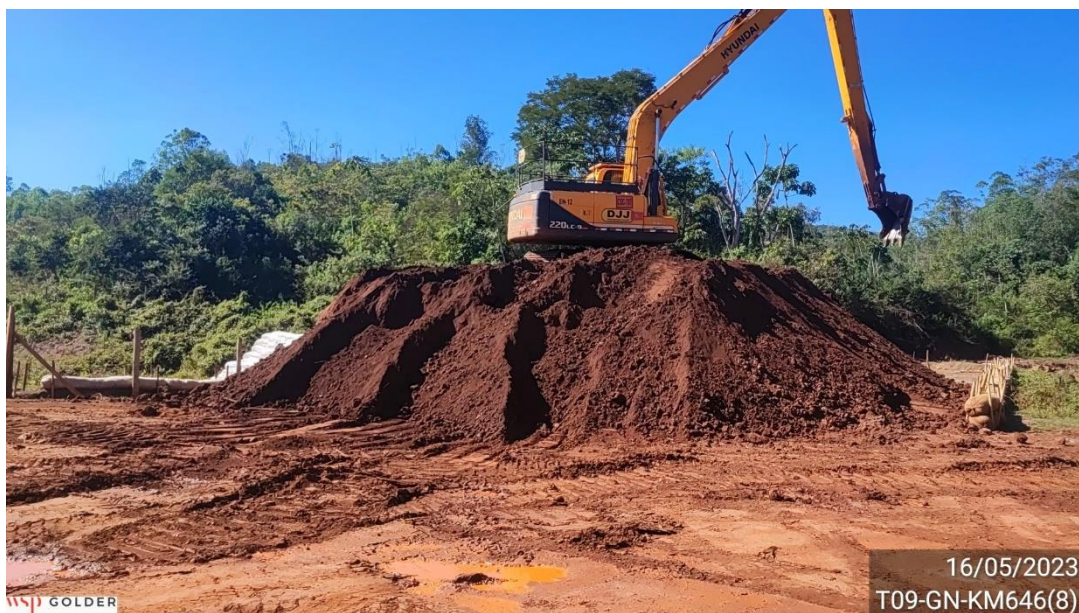
Figura 6 - Tombamento do material disposto nas áreas de secagem
