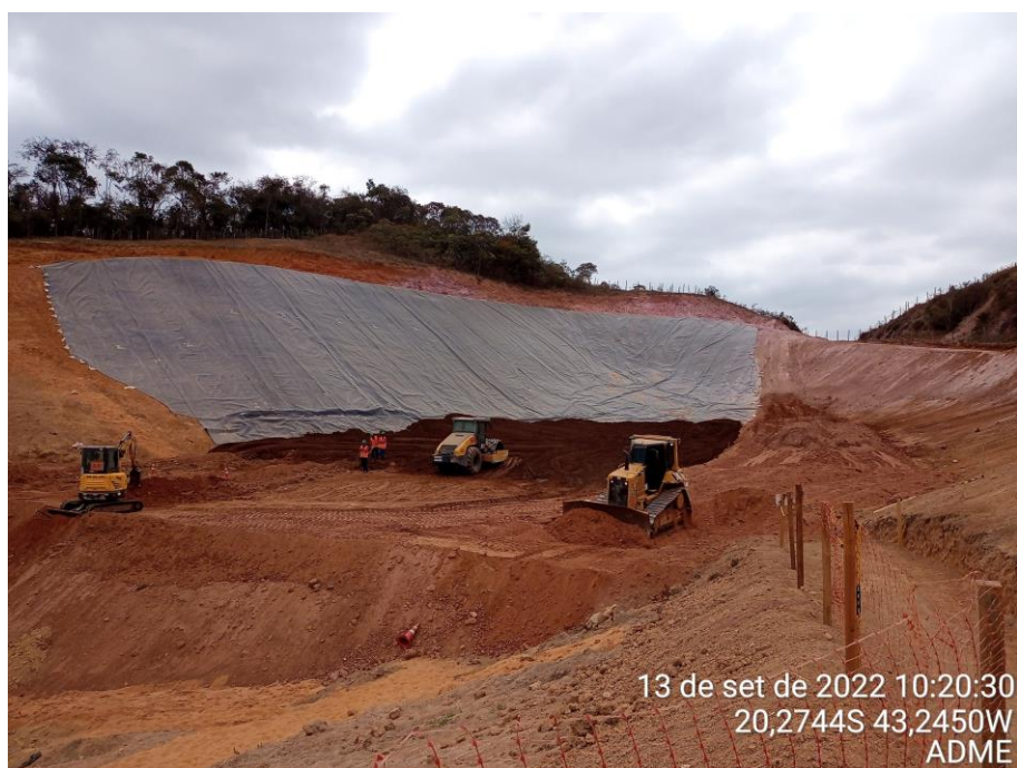
Figura 58 - Aplicação da geomembrana e distribuição das camadas de rejeitos e argila e compactação.
