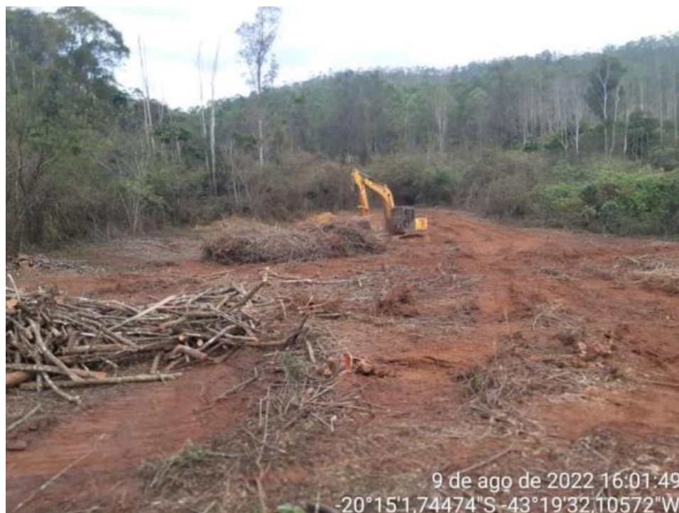
Figura 38 – Supressão da vegetação para escavação das lagoas marginais em área trabalhada pelo PG25.
