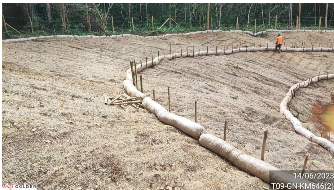
Figura 10 - Instalação de bioretentores nos taludes das lagoas
